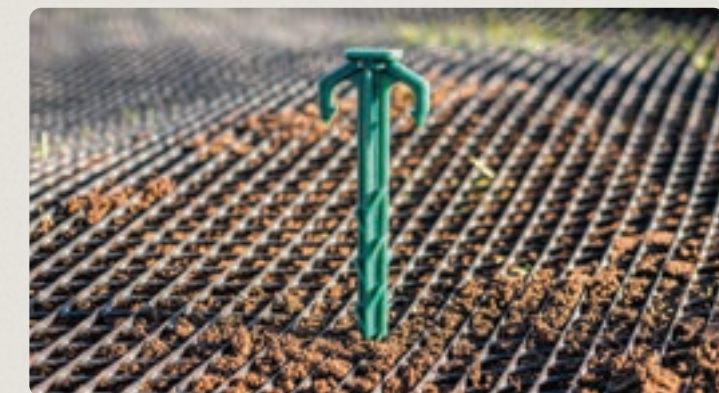
Schneller Einbau mit BIO-Erdankern und anschließender Rollrasenverlegung.
