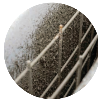
Vlieskaschierung verbindet sich sofort mit dem Frischbeton
