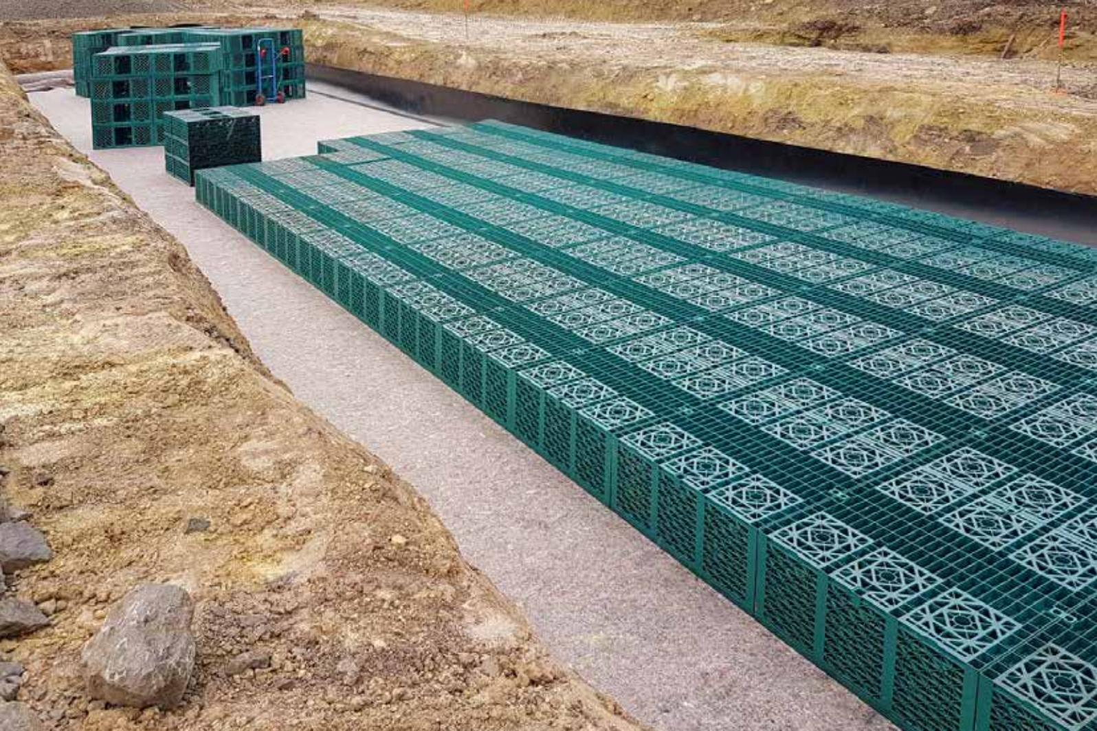
Mit RigoCollect können auf einfachste Weise unterirdische Speicher gebaut werden. Dazu werden Rigofill inspect Speicherblöcke in Spezialtechnik mit einer Kunststoff-Dichtungsbahn ummantelt. So entsteht ein absolut dichtes, unterirdisches Bauwerk. Kompakt, leicht, wirtschaftlich und flexibel einsetzbar.
